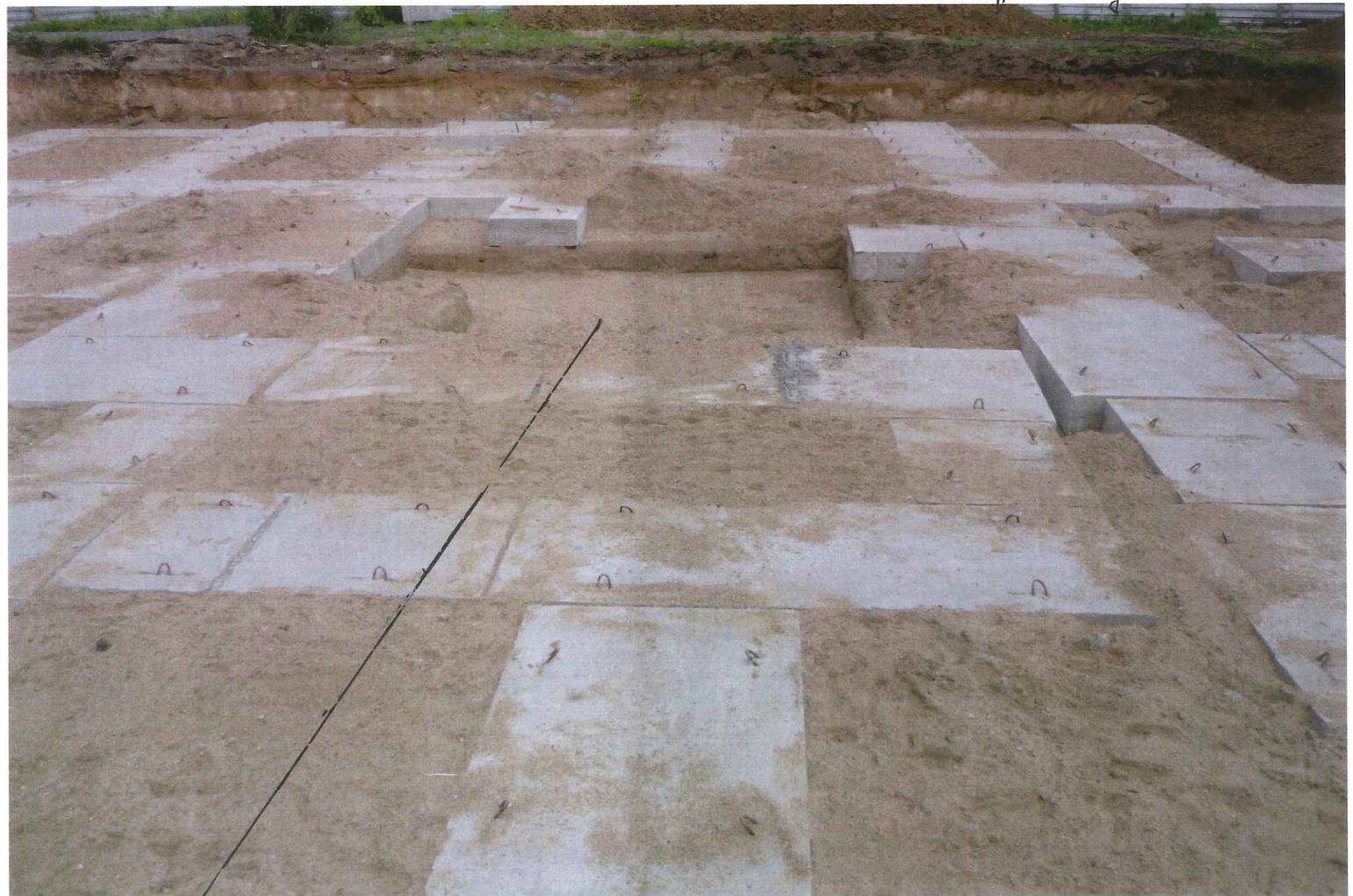
лестнично-лифтовой узел из монолитн. #/бетона
