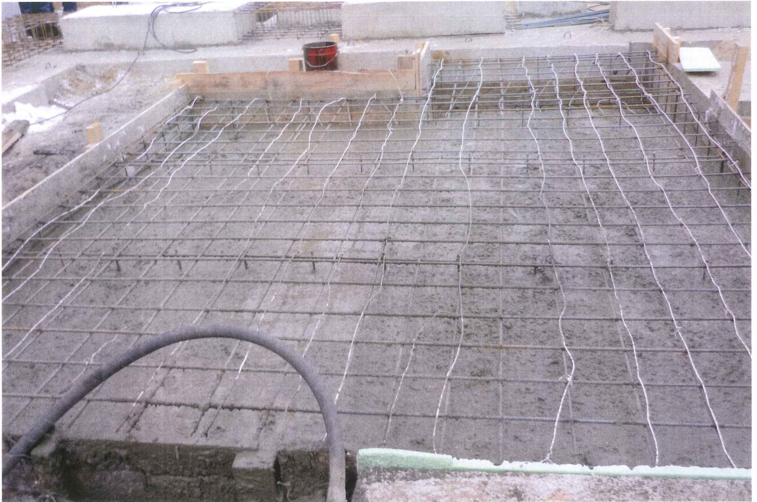
16.11.2017 Штукатур дом №122 Section. 9-та под лестнично-лифтовой узел
