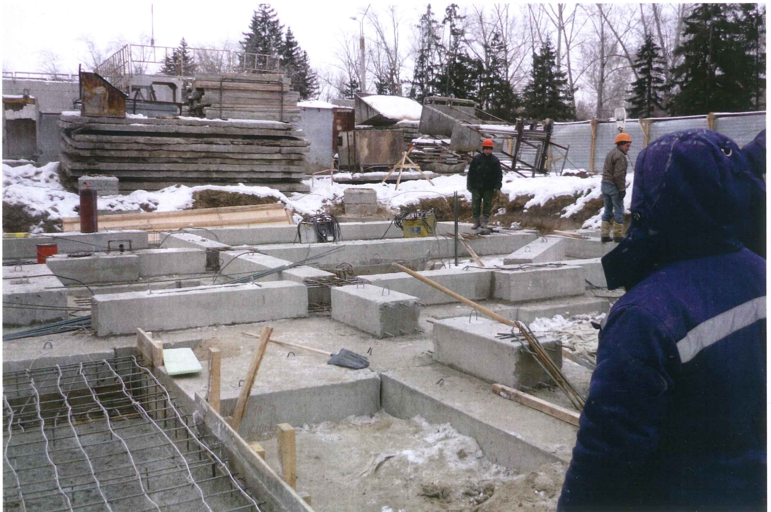
Штукатур дом №122 9-та на 16.11.2017
